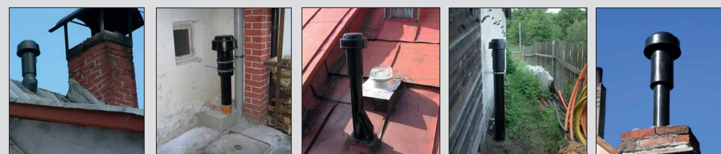
Obr. 4 – Alternativy osazení ventilátorů, které aktivují stávající přirozené odvětrávací systémy.
